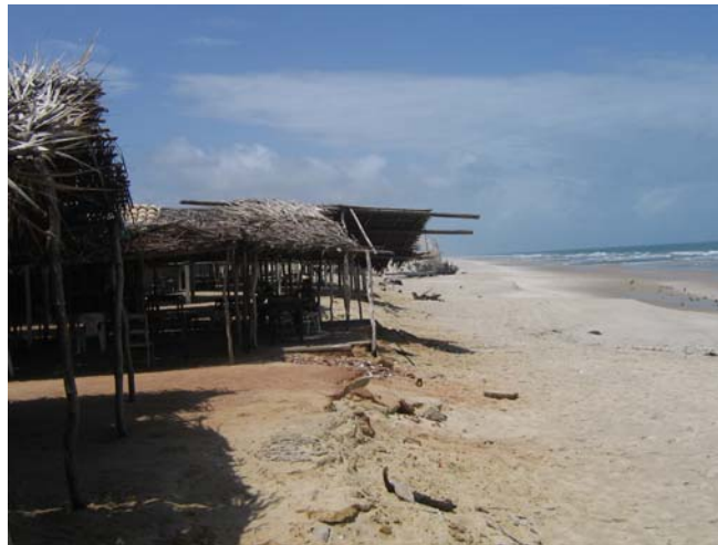
Figura 2 – Barracas de praia do Batoque destruídas por eventos de erosão de praia. Foto do Autor. Janeiro de 2008.
