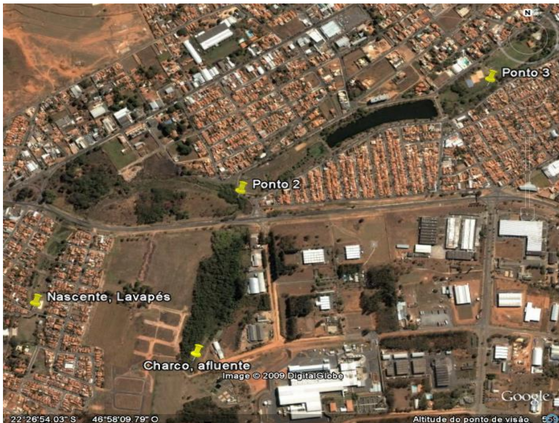
FIGURA 1: Vista aérea do córrego Lavapés e de seu afluente Fonte: www.googleearth.com
