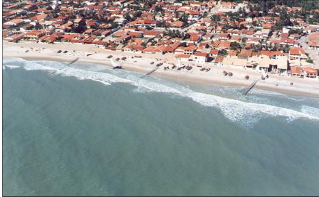
Figura 2: Obra de reabilitação da praia. (FONTE: Pinheiro, 2000)
