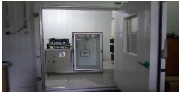
Figura 1: Sistema de refrigeração estudado.
